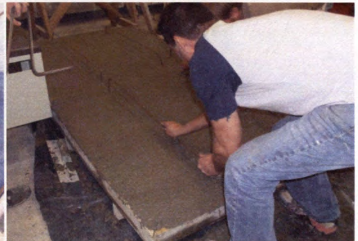
(d) Placing the Stirrups
