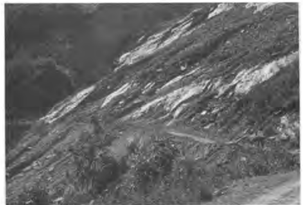
FIG. 9 Narak Landslide, Sikkim.
