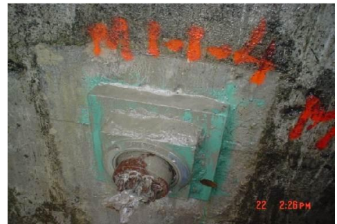
Fig. 15 (d) Grouting Completed
