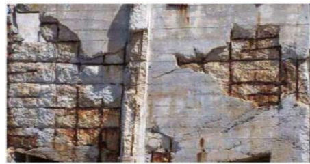
Spalling
